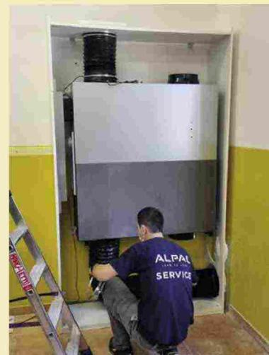
6 - Collegamento dei canali di estrazione e immissione aria
